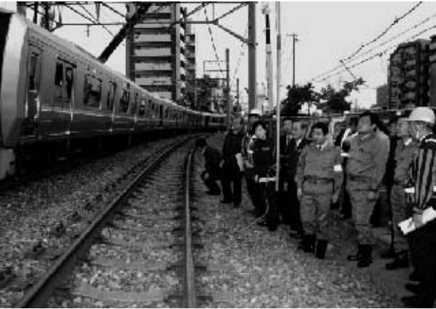
JR福知山線・列車転覆事故現場を視察する赤羽かずよし衆議院議員を始めとする公明党緊急対策本部視察団
